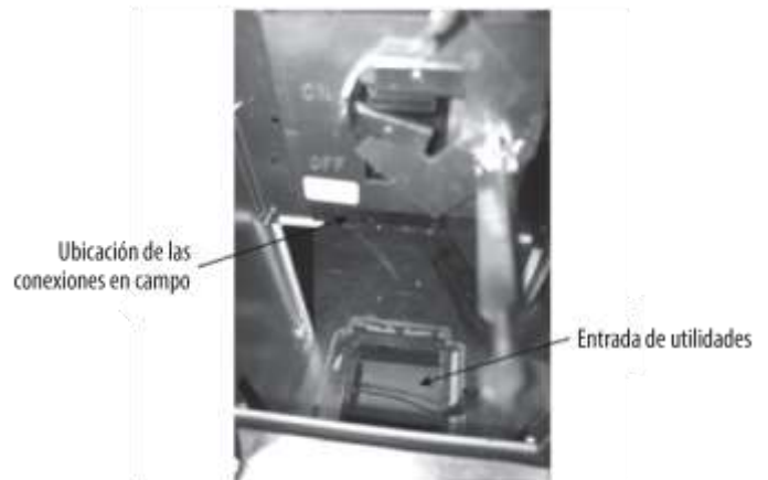
Figura 23 - Vista frontal de la Entrada de Utilidades y del Interruptor de Corriente del Compartimiento de Controles (Unidades de 55, 65, y 75-140 toneladas).
